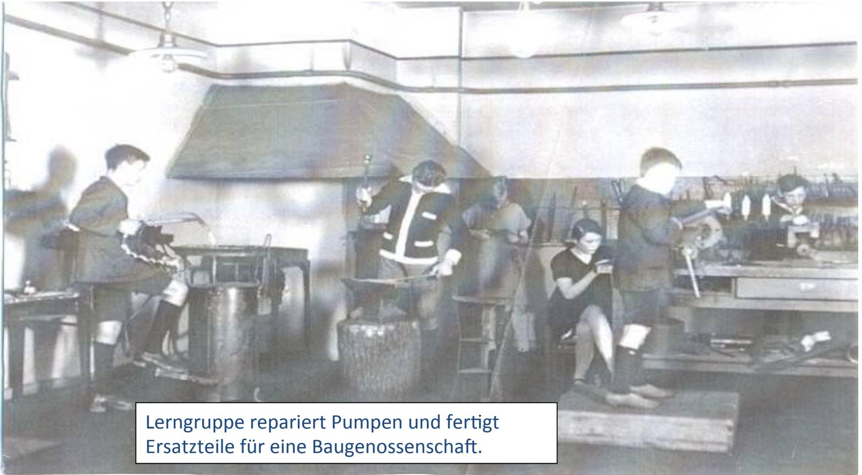
Lerngruppe repariert Pumpen und fertigt Ersatzteile für eine Baugenossenschaft.
